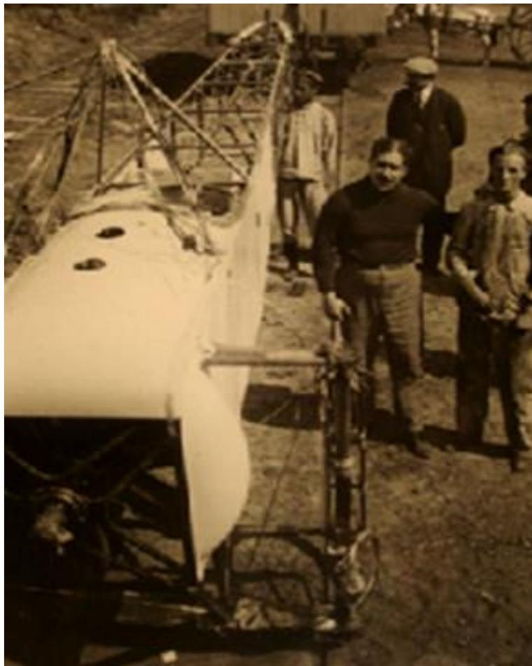
La carga y descarga de los aeroplanos para su traslado en carros y ferrocarril era una de las funciones atribuidas al personal de la Compañía Aeronáutica. En la foto se observa el procedimiento para embarcar un Blériot XI Bis en la estación de El Palomar, ferrocarril “Del Pacífico”. En primer plano el Ingeniero Alberto Mascías y el Jefe de Mecánicos de la E.A.M., Ambrosio Garagiola, detrás, un soldado de la Compañía Aeronáutica. Año 1913.
